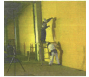
墨出し割付け
